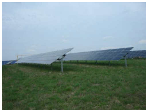
Abbildung 25: Solaranlage in der Nähe von Gottmadingen
